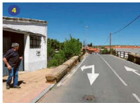
Un puente sin aceras. Un tramo de la calle San Ildefonso carece de aceras, concretamente el que coincide con el puente sobre la vía férrea. En paralelo a este viaducto se levantará una nueva pasarela de uso exclusivo para peatones y ciclistas.
