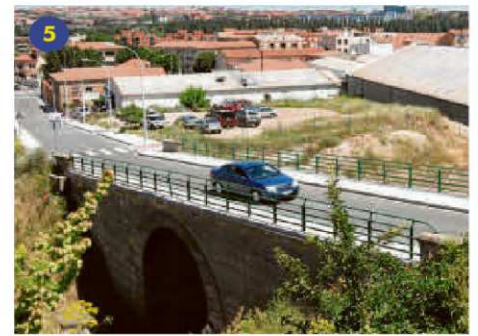
El viaducto de Chamberí se ensancha. El viaducto de la calle Avena, entre Chamberí y Los Alcaldes, tiene actualmente 7,5 metros de ancho. El Consistorio proyecta ensancharlo hasta los 12 metros, y mejorar su iluminación.
